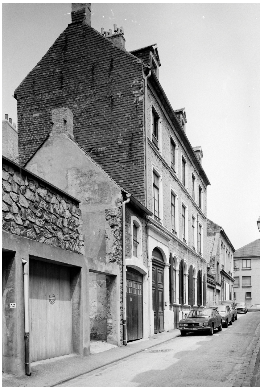
Vue d'angle sud-ouest.
