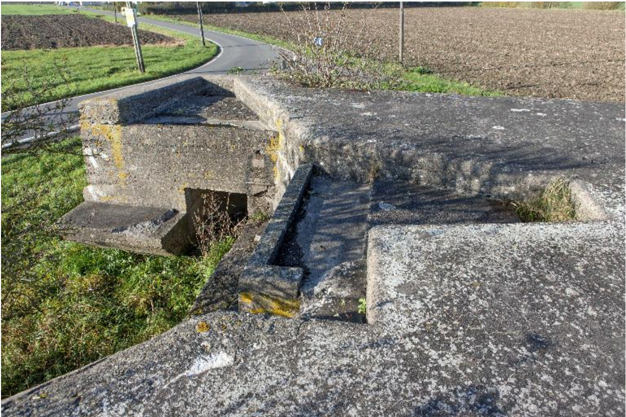
Vue des cuves à mitrailleuse, vers le sud-ouest
