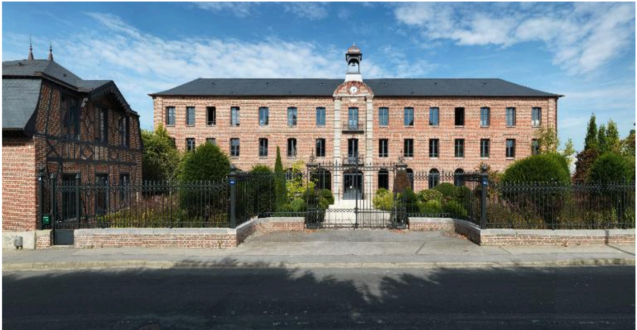
Vue des anciens ateliers de fabrication de l'usine Laperche, aujourd'hui Showroom de l'entreprise Delabie.
