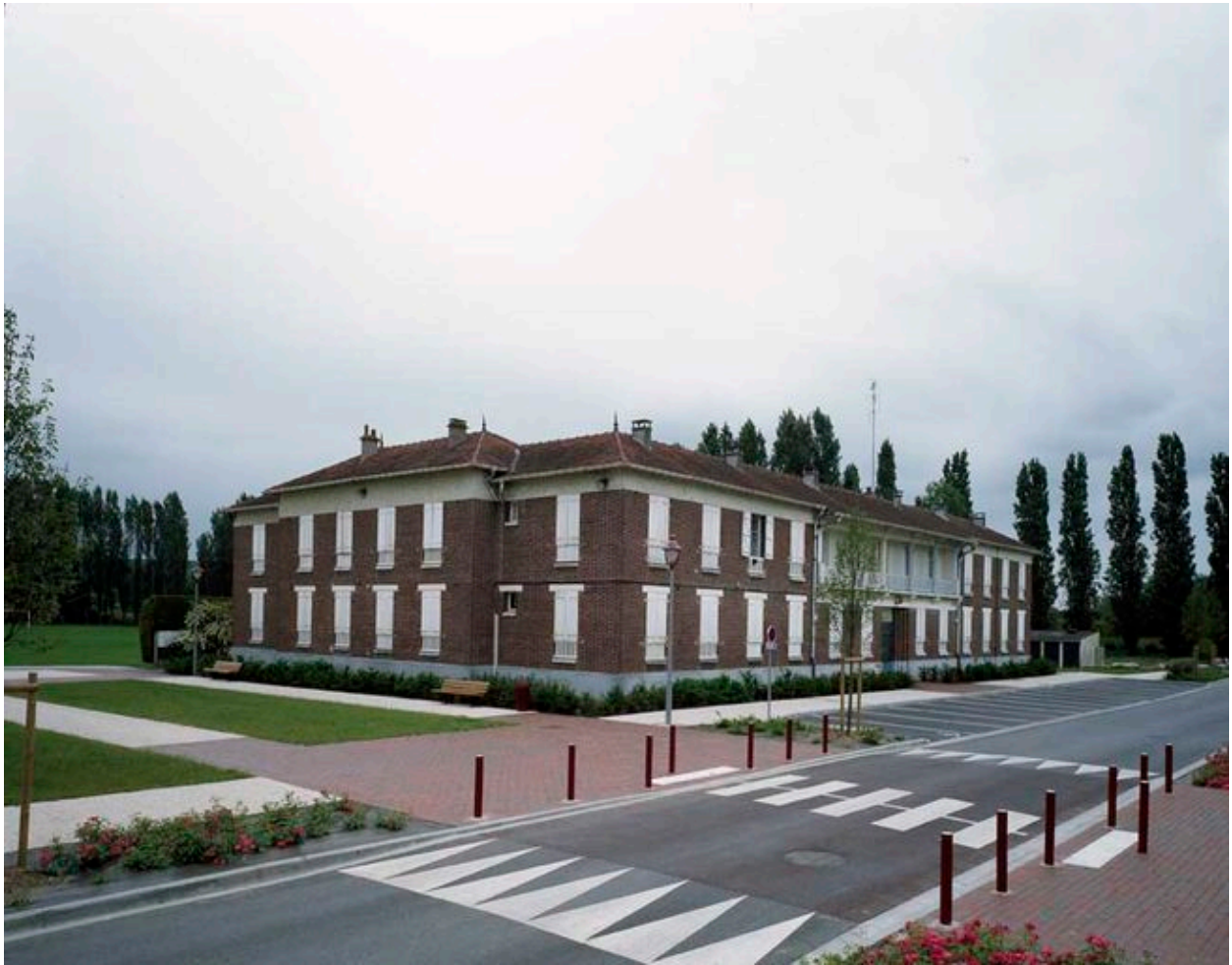
Bâtiment 520 : Vue générale.
