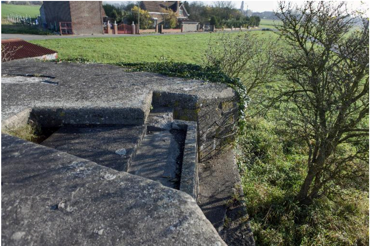
Vue de cuve à mitrailleuse centrale, vers l'est
