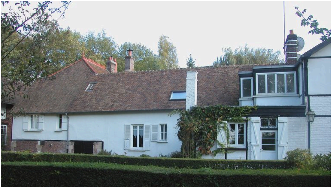
Façade postérieure du logement patronal.
