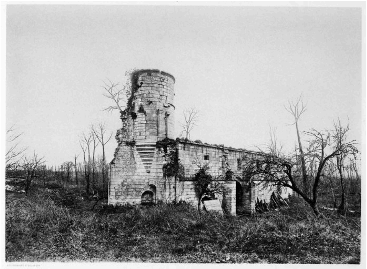
Vue des vestiges de l'ancienne l'infirmerie par P. Dujardin (In : La Picardie historique et monumentale).
