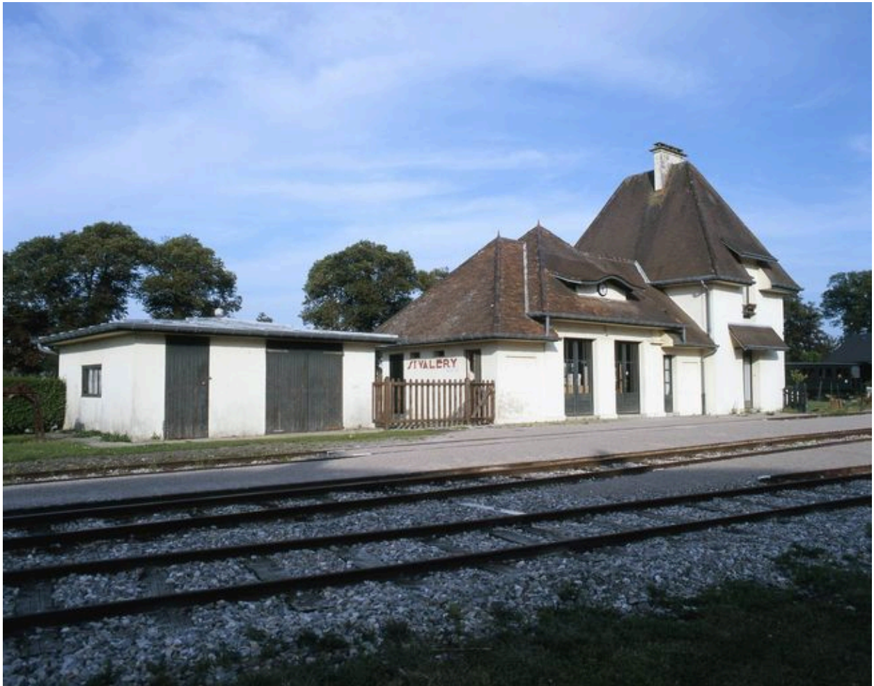
Elévation postérieure, côté rails.
