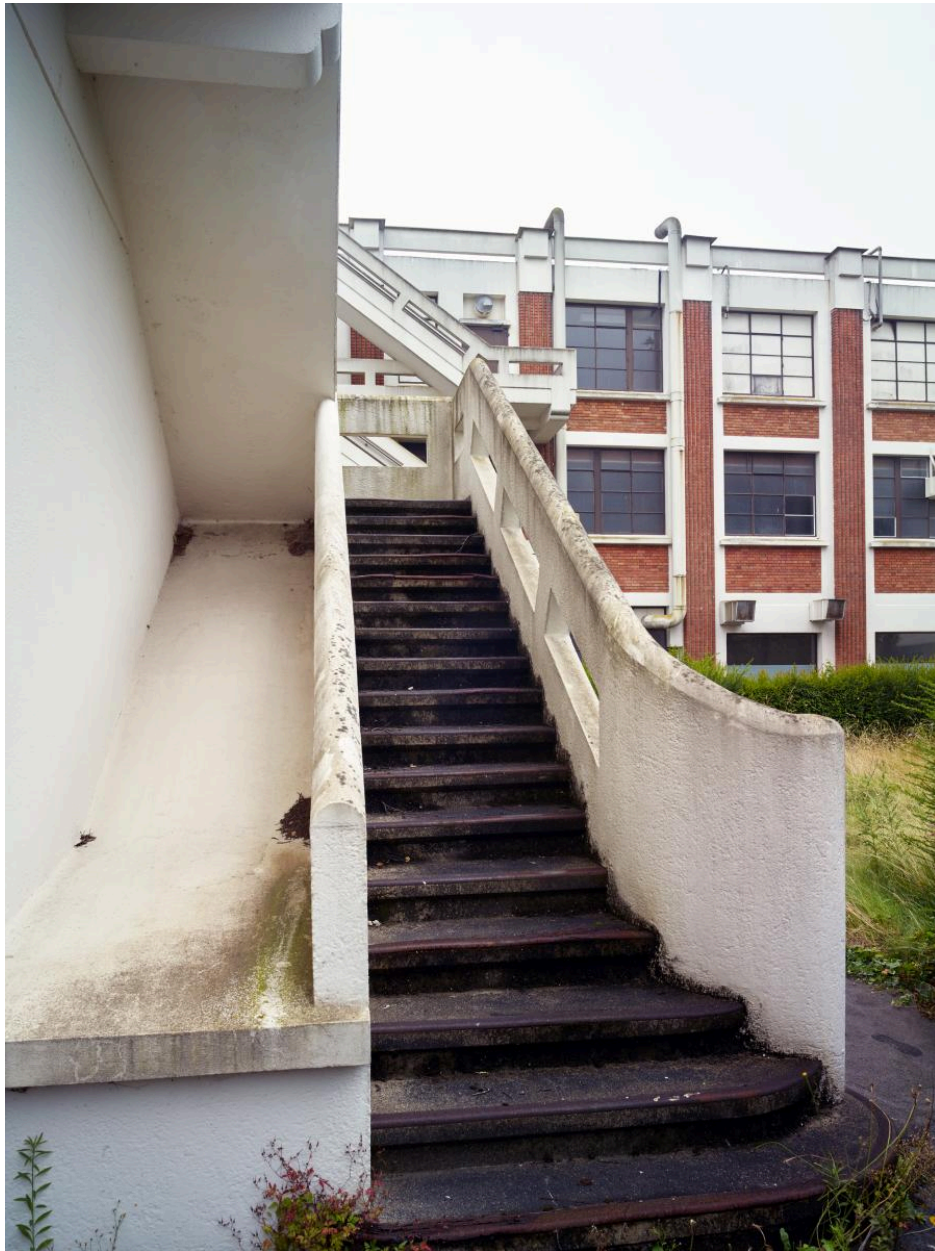
Pignon ouest abritant bureaux et logements (E). Escalier desservant le logement du directeur (au premier et second étage).
