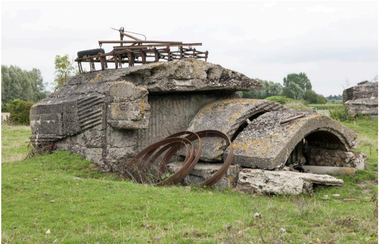
La casemate en 2015, vers l'ouest
