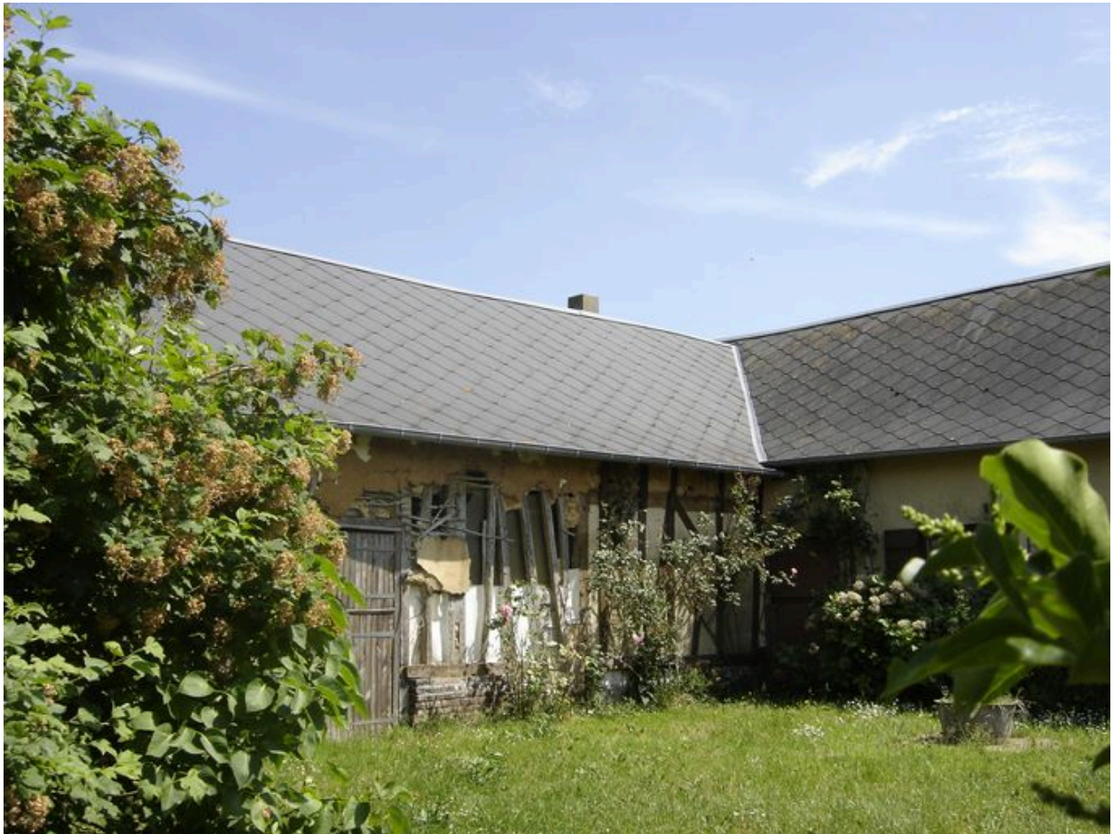
Vue partielle des écuries.
