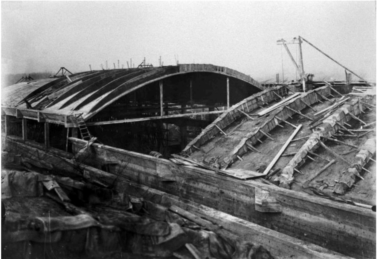
Détail de la construction des voûtes des ateliers en béton armé, vers 1922 (AC Thourotte).
