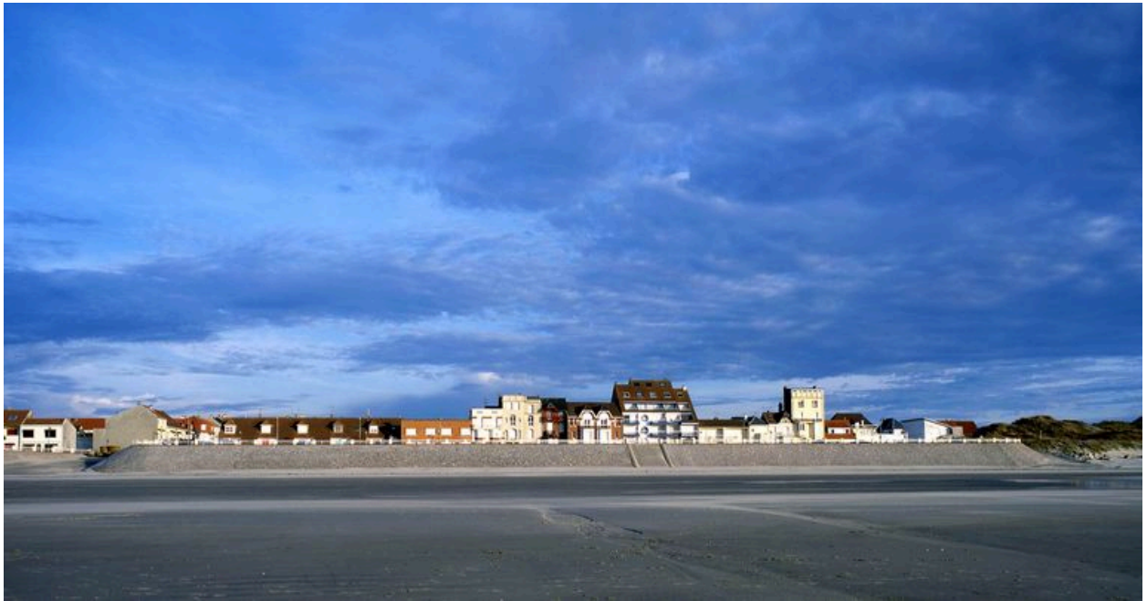
La digue sud, vue d'ensemble depuis la plage.
