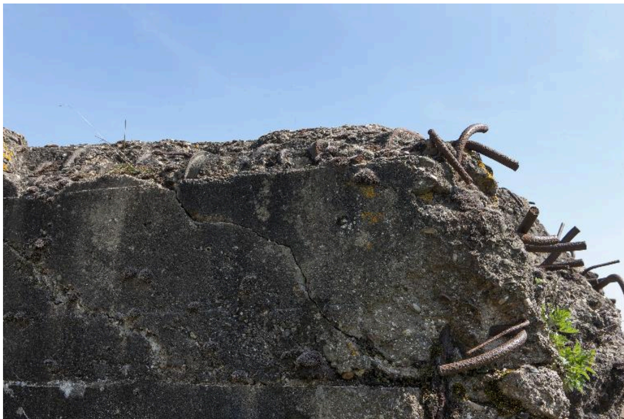
Partie est, détail du béton et des fers
