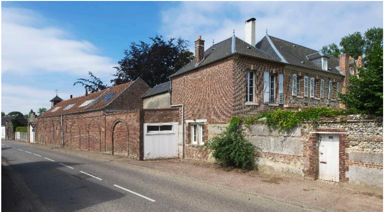
Vue de trois-quarts de l'ancien logement patronnal ainsi que des anciens ateliers de l'usine.
