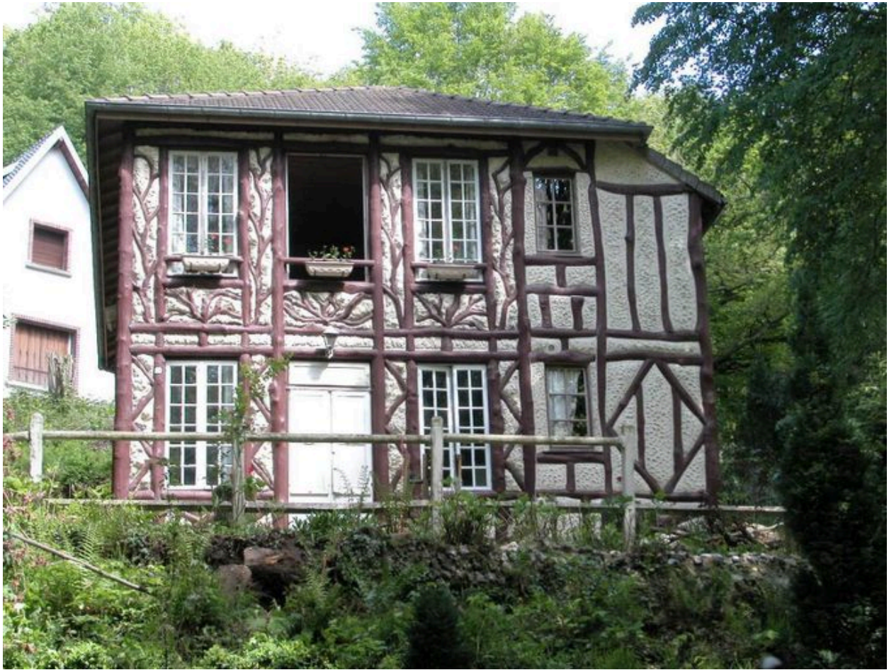
Vue d'ensemble avant changement des huisseries.
