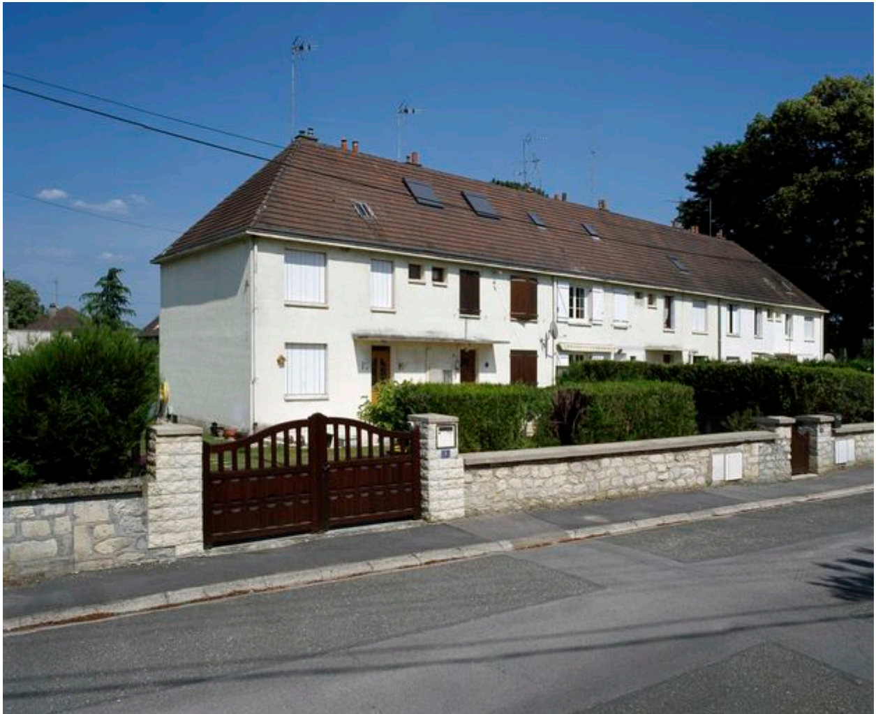
Logements collectifs de la cité de la Garenne.
