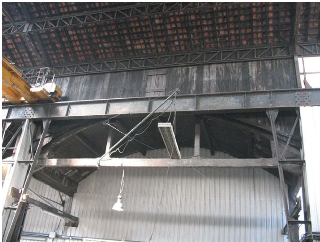
Détail des poutrelles métalliques.
