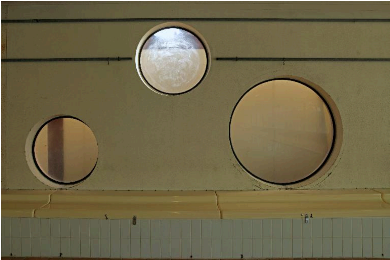
Jeux d'ouvertures circulaires, sur une des façades latérales de la piscine.
