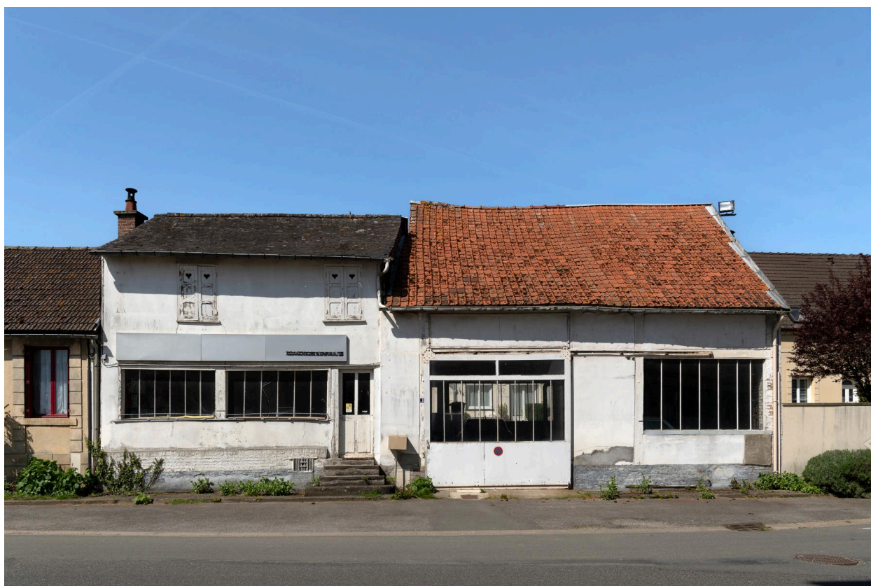
Ancien garage, n°8 de la rue Saint-Pierre, vue prise depuis l'est.
