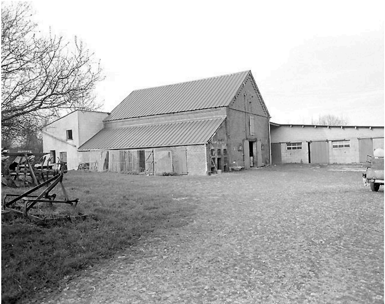
Vue de la cour intérieure : grange-étable.
