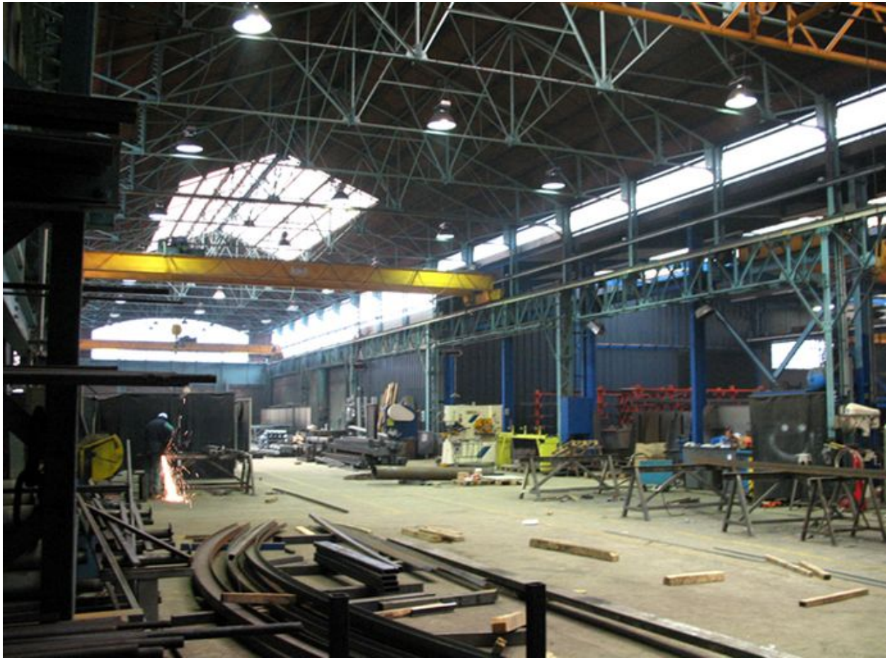
Zone de transbordement des poutrelles.
