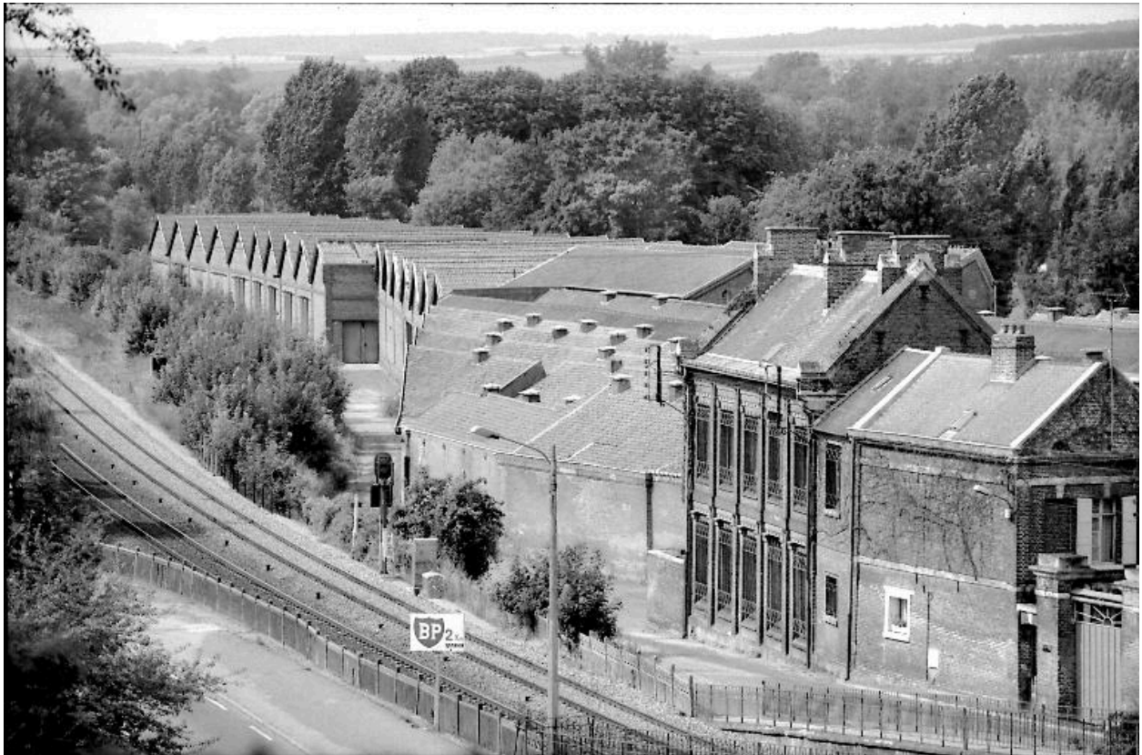
Vue partielle, depuis le sud-est.
