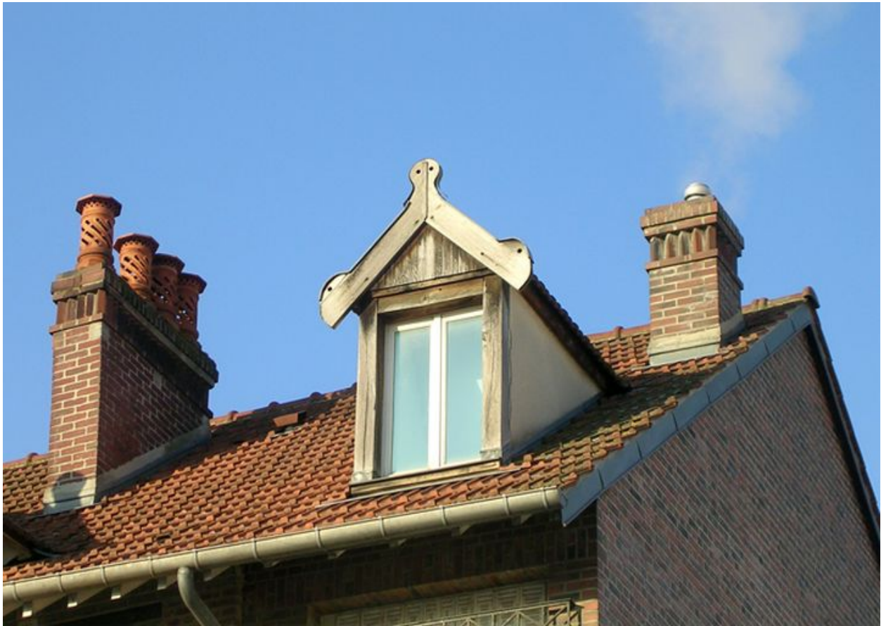
Détail de la toiture.
