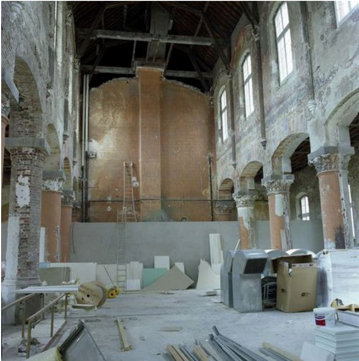
Chapelle, vaisseau central, vue générale en regardant vers l'entrée.
