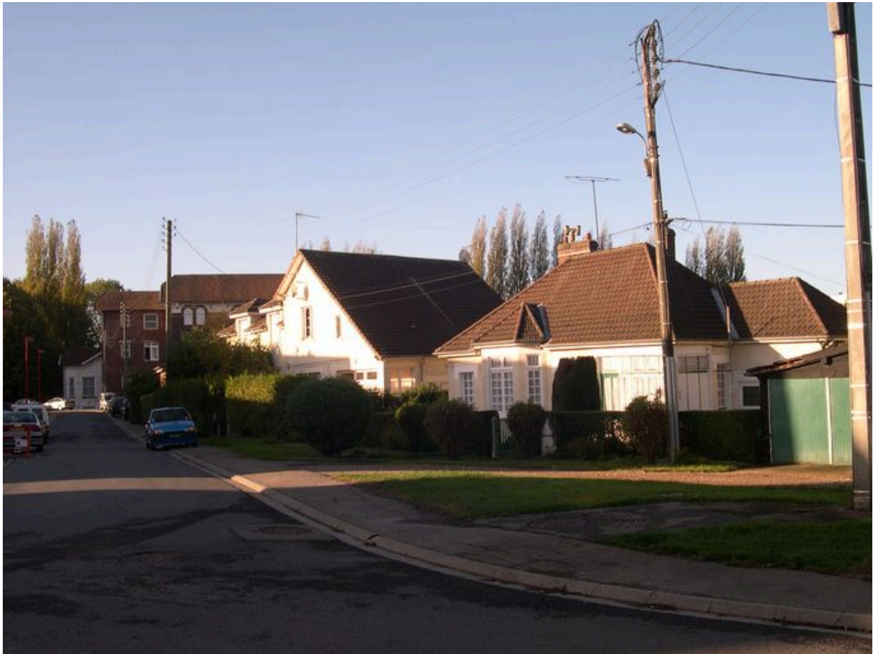
L'allée des Acacias, vue prise depuis le nord. Au premier plan maison à une unité d'habitation (modèle A), 15 rue des Acacias. Vue prise en 2004 avant restauration.
