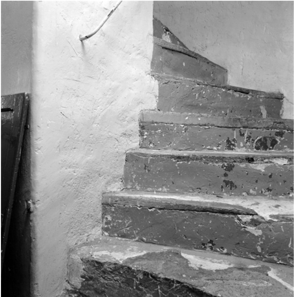
Départ de l'escalier principal.
