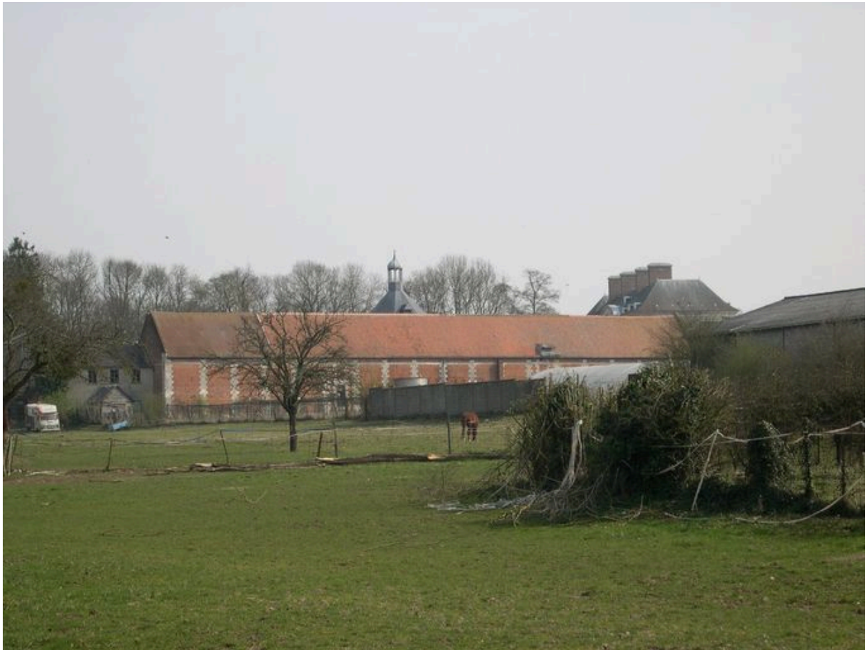
Vue de situation depuis la rue du Moulin.
