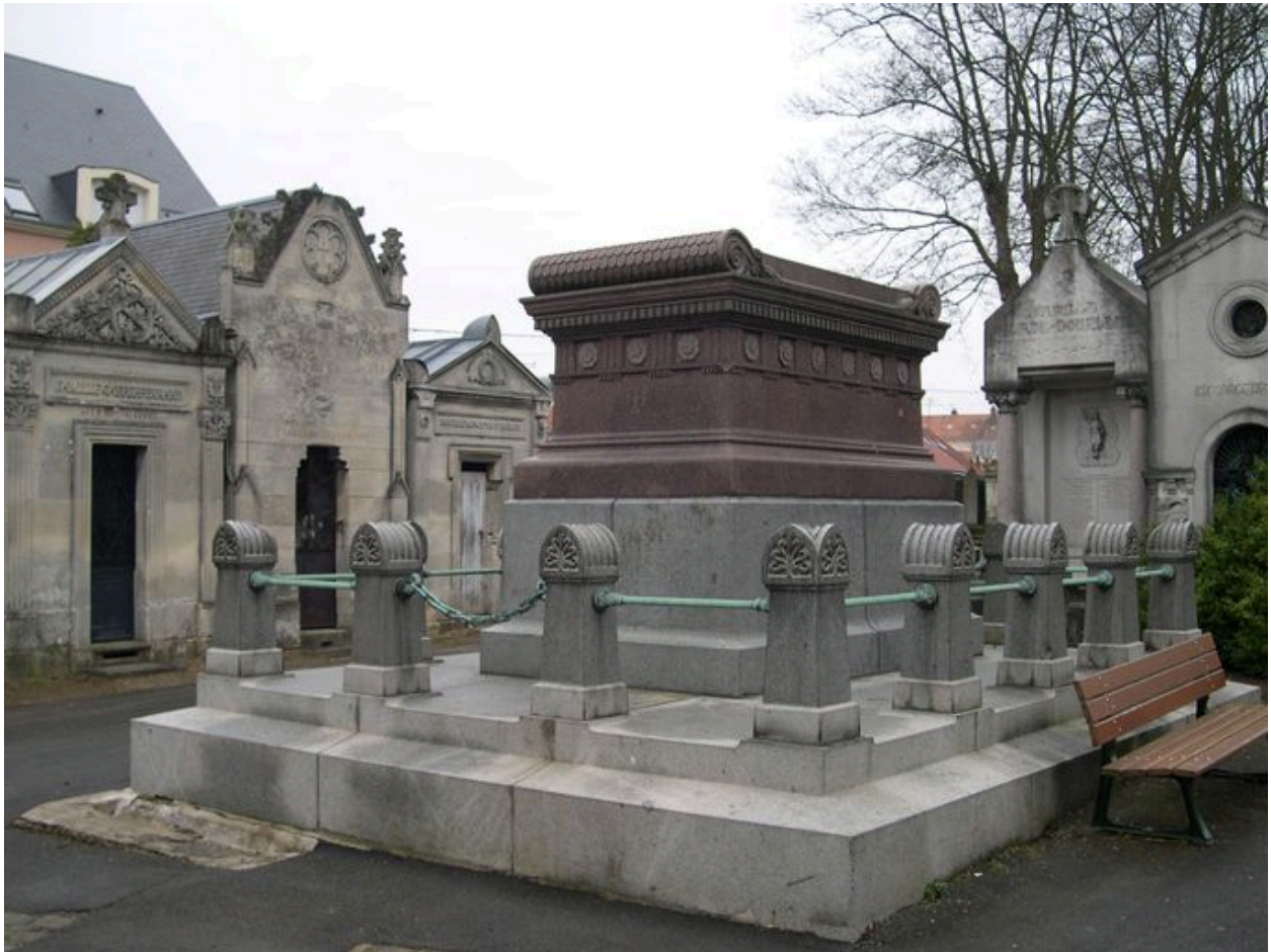
Vue générale, depuis le nord-ouest.
