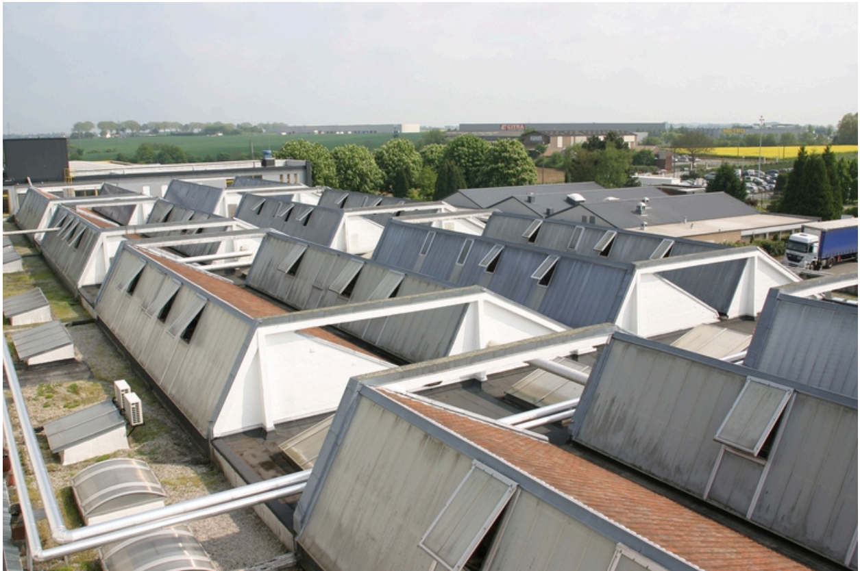
Les sheds des ateliers de 1929.
