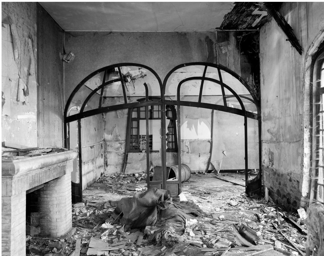
Portes-fenêtres jumelées : vue de l'intérieur.
