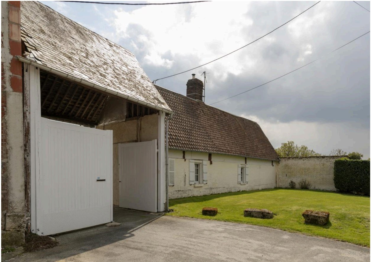
Entrée charretière et logis, n°6 Impasse des Vignes, vue depuis le nord-est.
