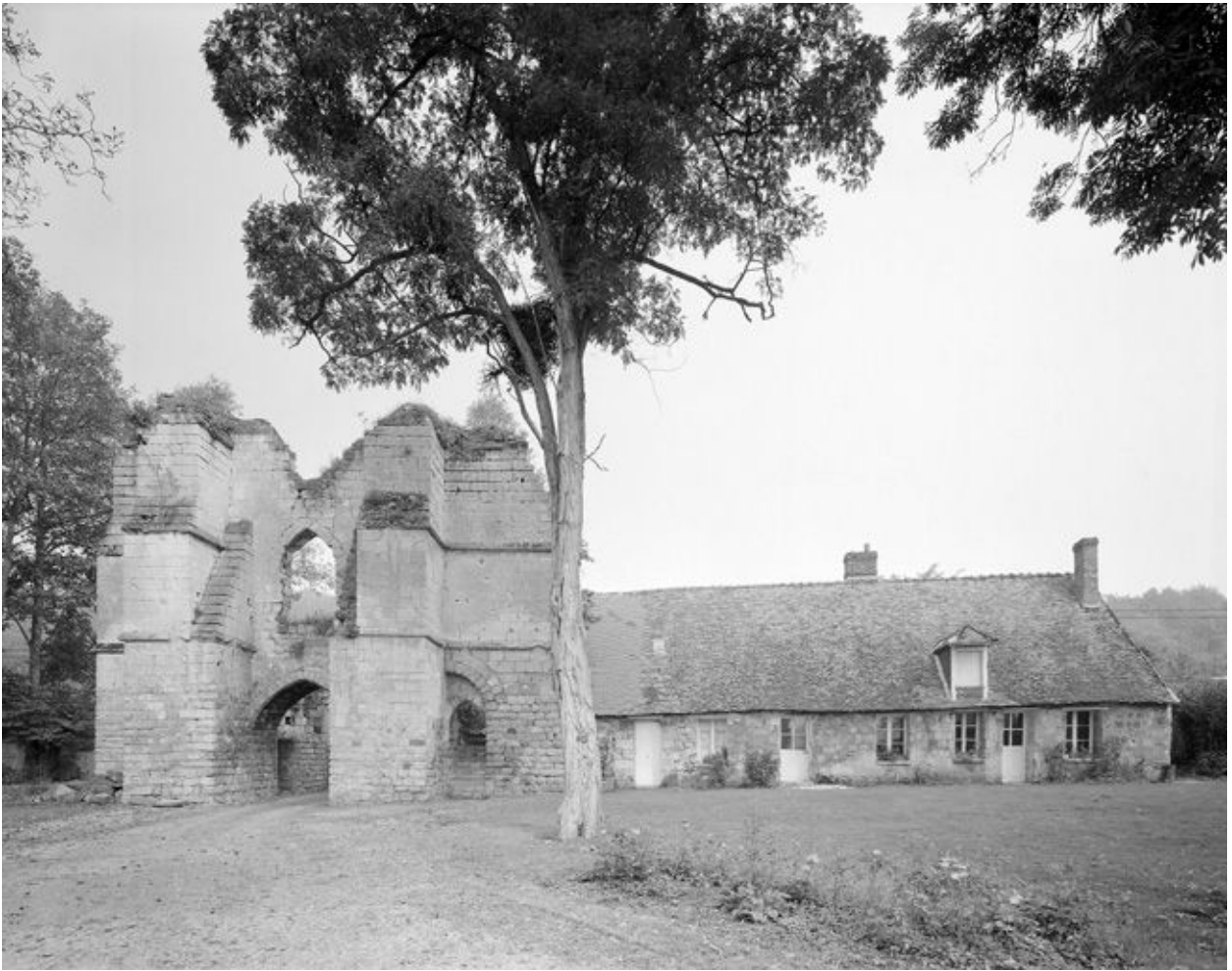
Ouvrage d'entrée. Élévation postérieure.
