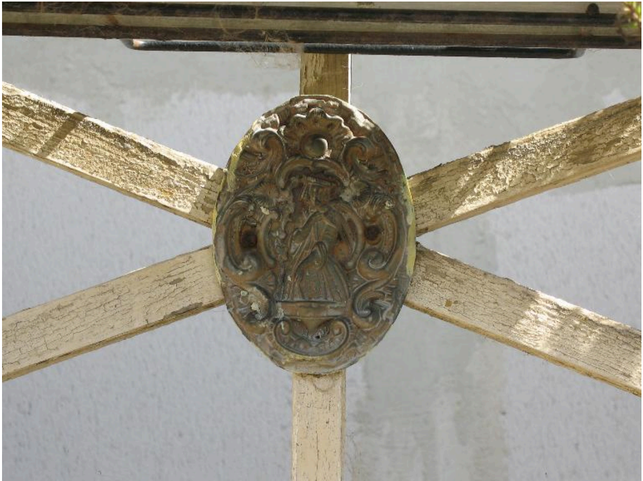
Médailles du garde-corps de la coursive.
