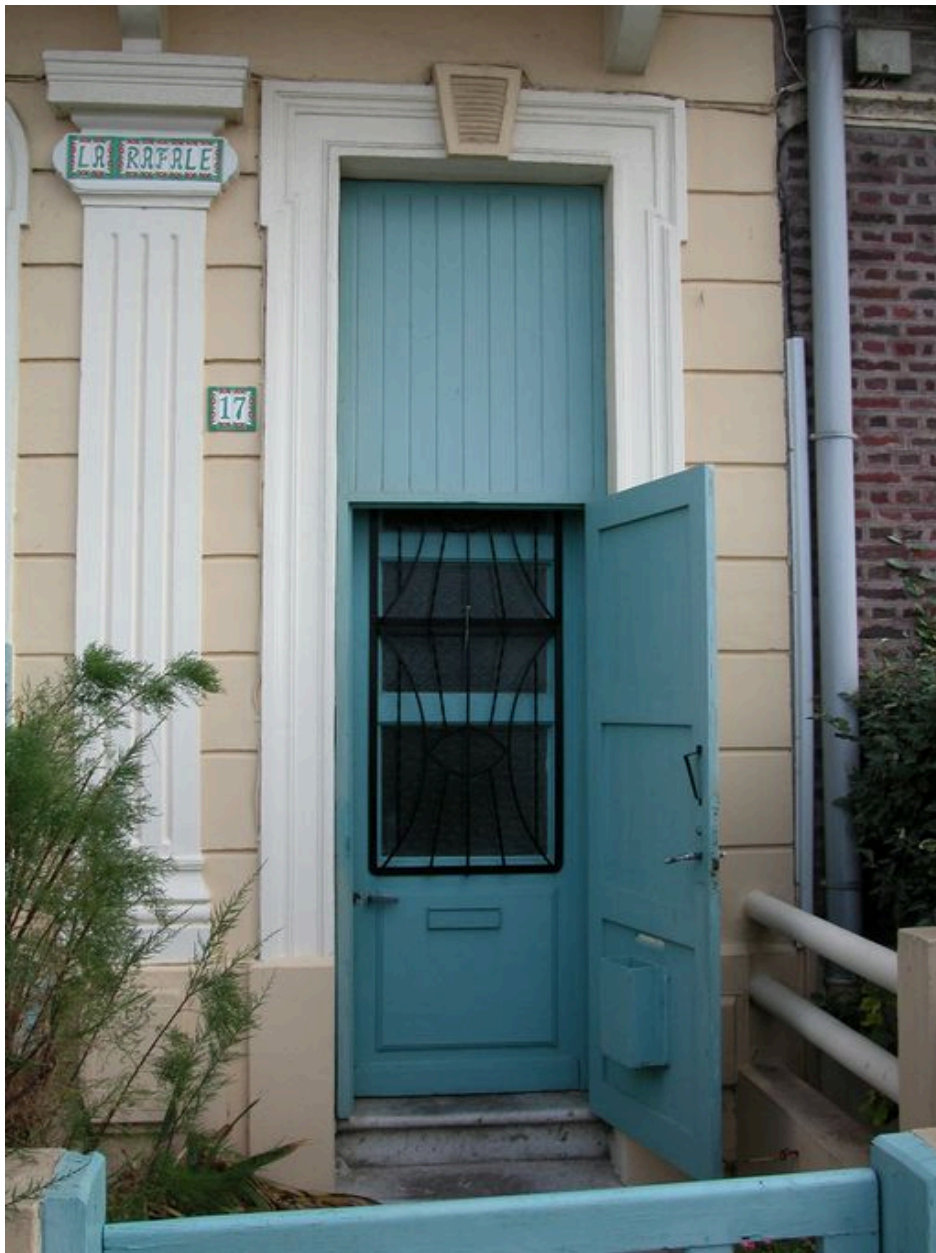
Détail de la double porte d'entrée.
