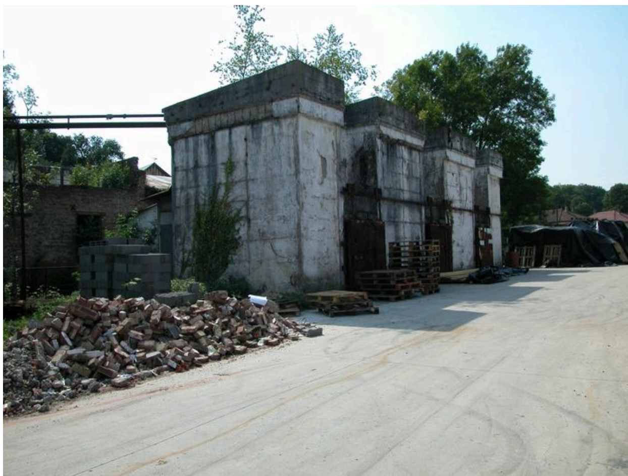
Atelier de rouissage des lins, façade sud.
