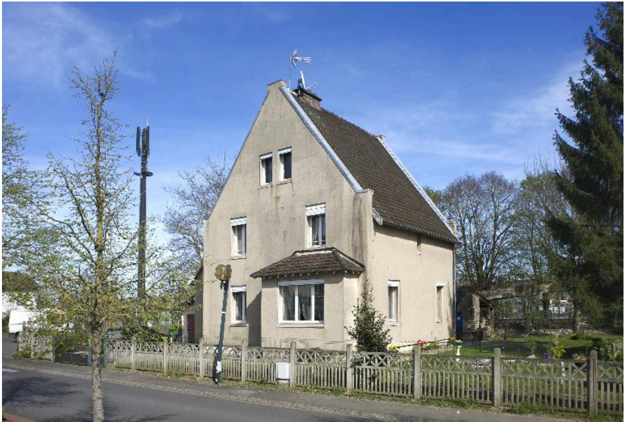
Maison, 14 place Herment. Au premier plan, la clôture d'origine.
