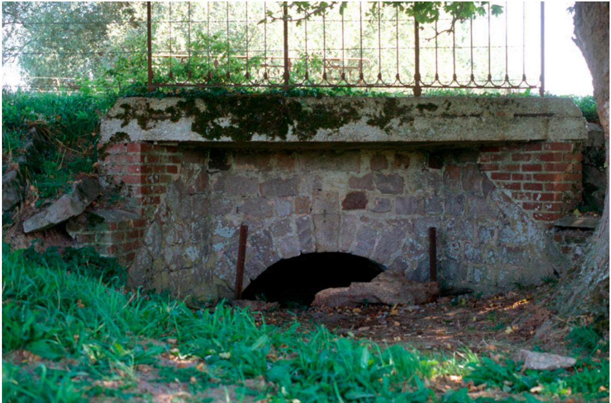
Petit pont de grès au sud du village, 1786.
