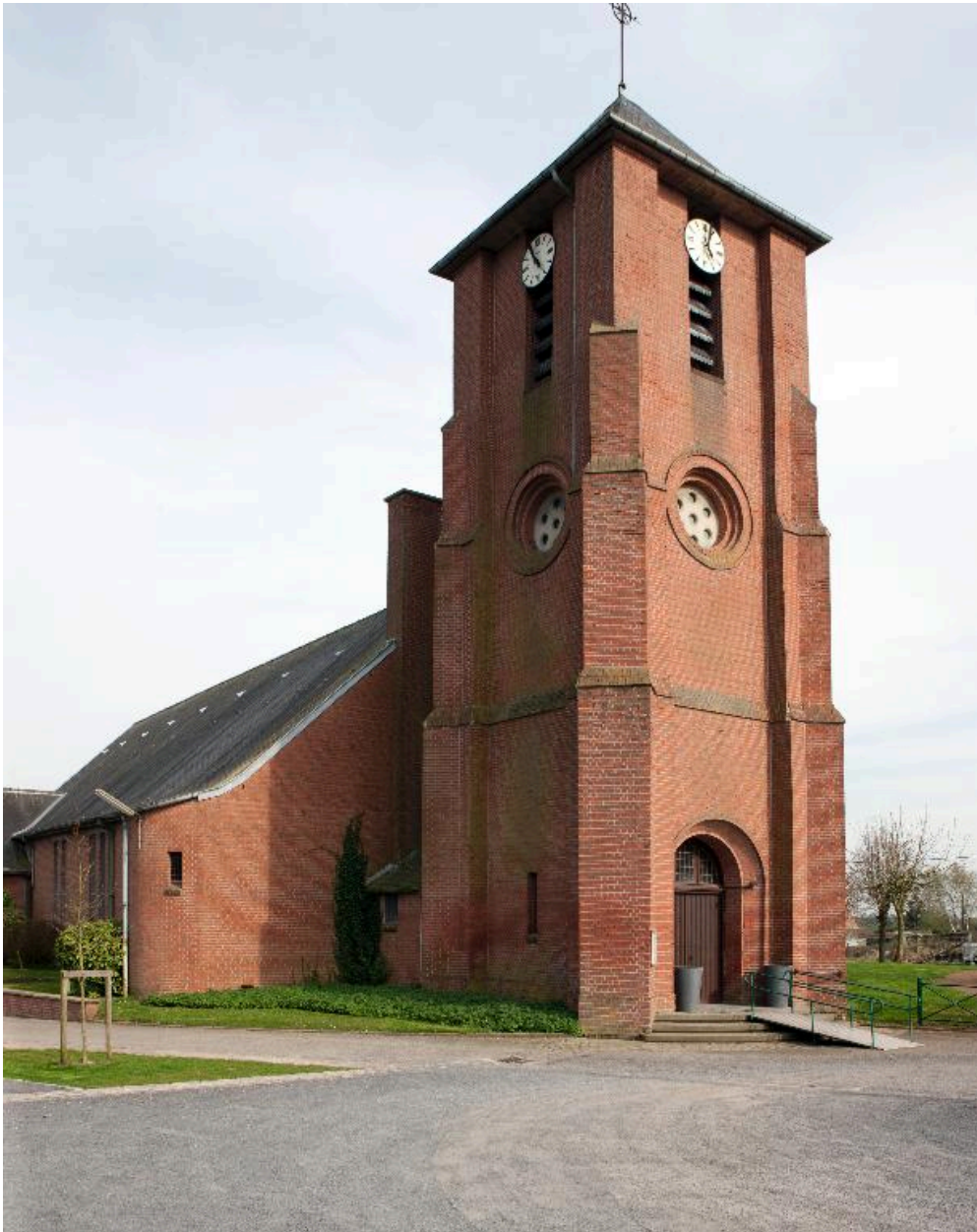
Vue générale de la façade occidentale.
