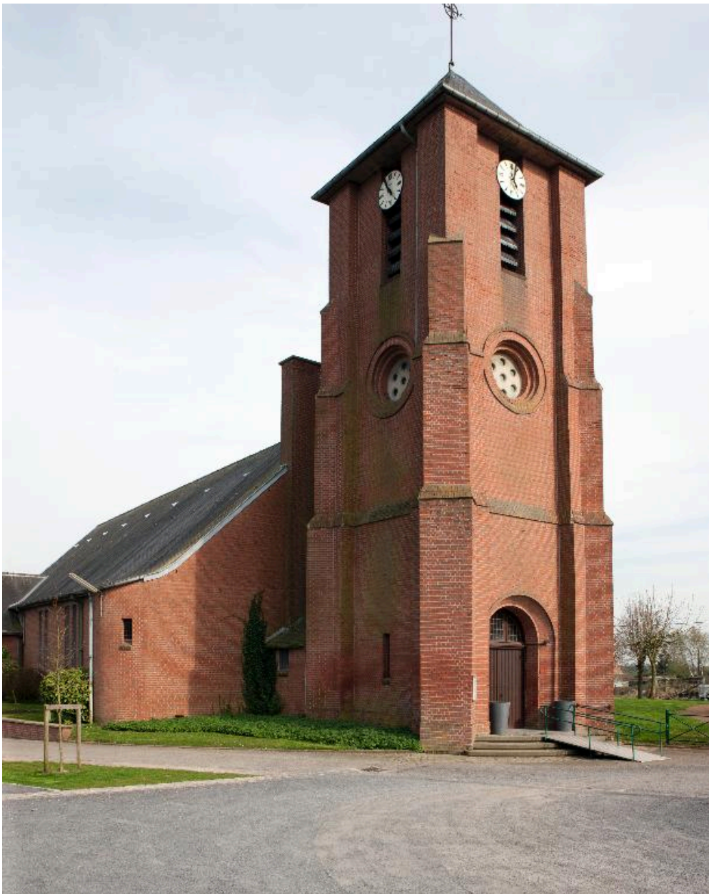
Vue générale de la façade occidentale.
