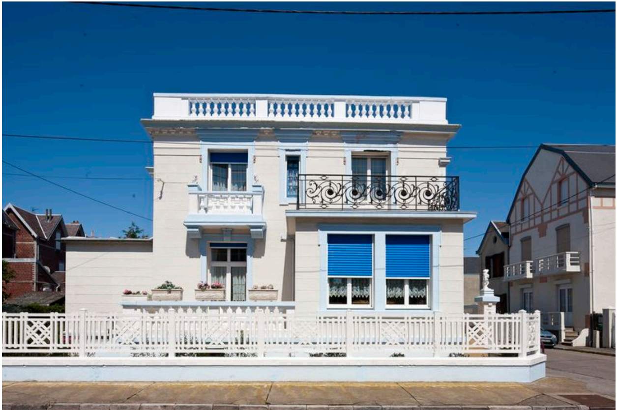
Vue générale de la façade méridionale.
