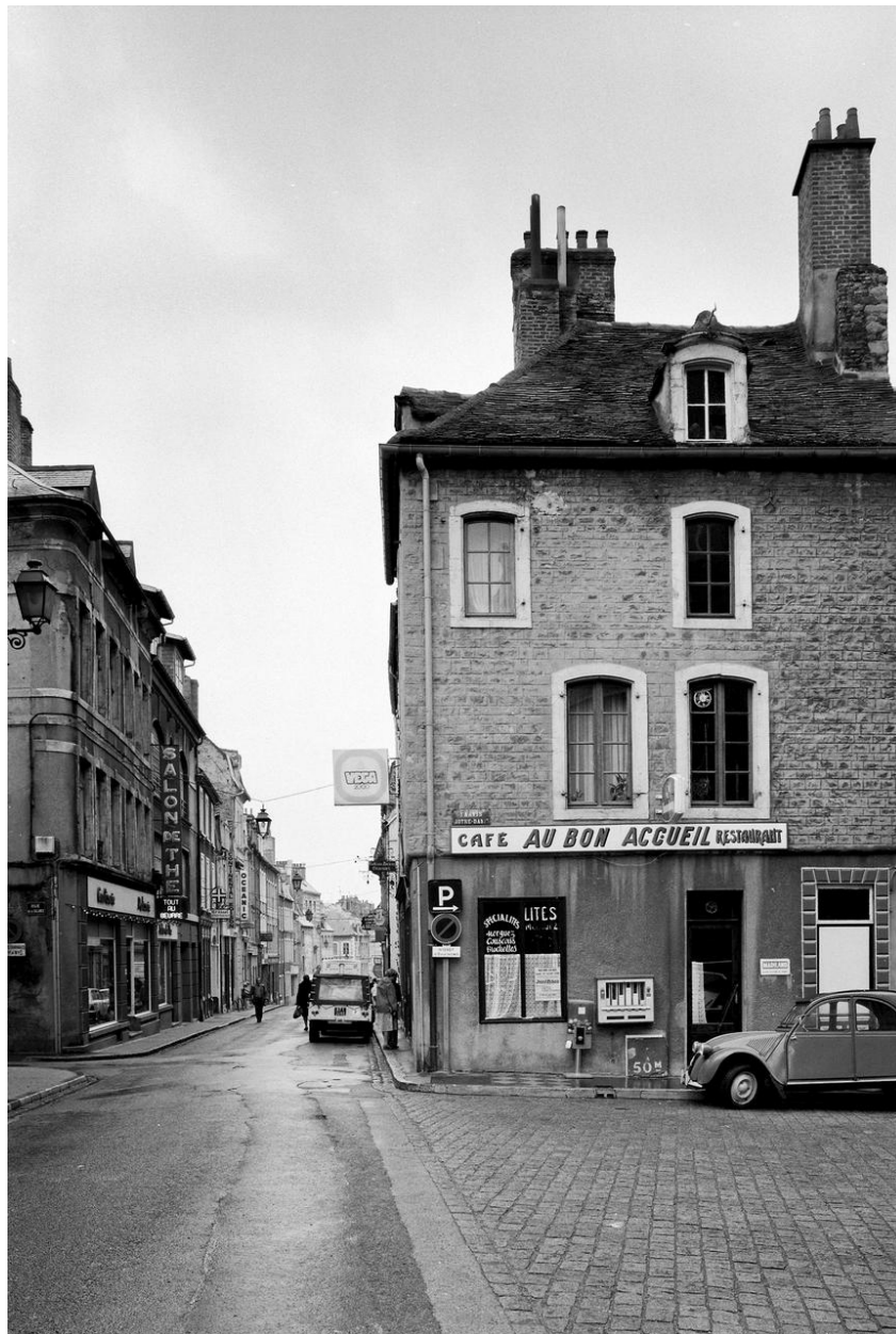
Façade rue du Parvis Notre-Dame.
