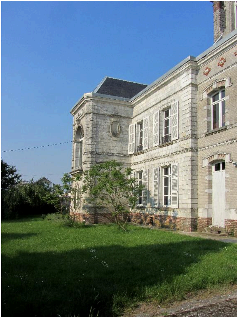
Façade postérieure, détail de l'avant corps central, vue de trois-quarts.
