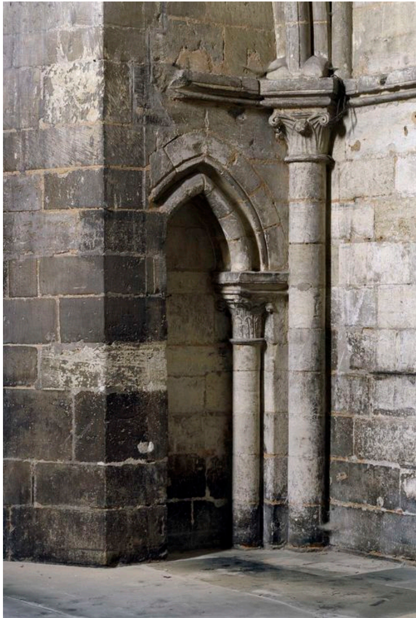
Arc ornant le mur occidental du rez-de-chaussée du clocher-porche.
