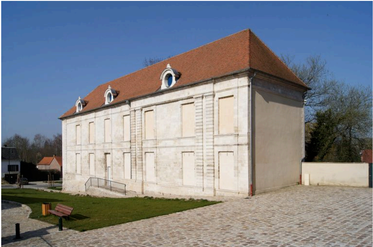
Façade principale de l'ancien logis abbatial.
