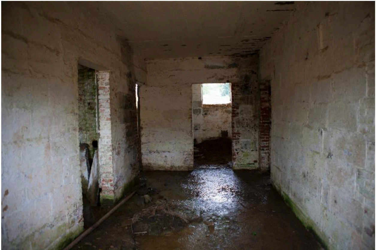
Abri casernement : vue intérieure.
