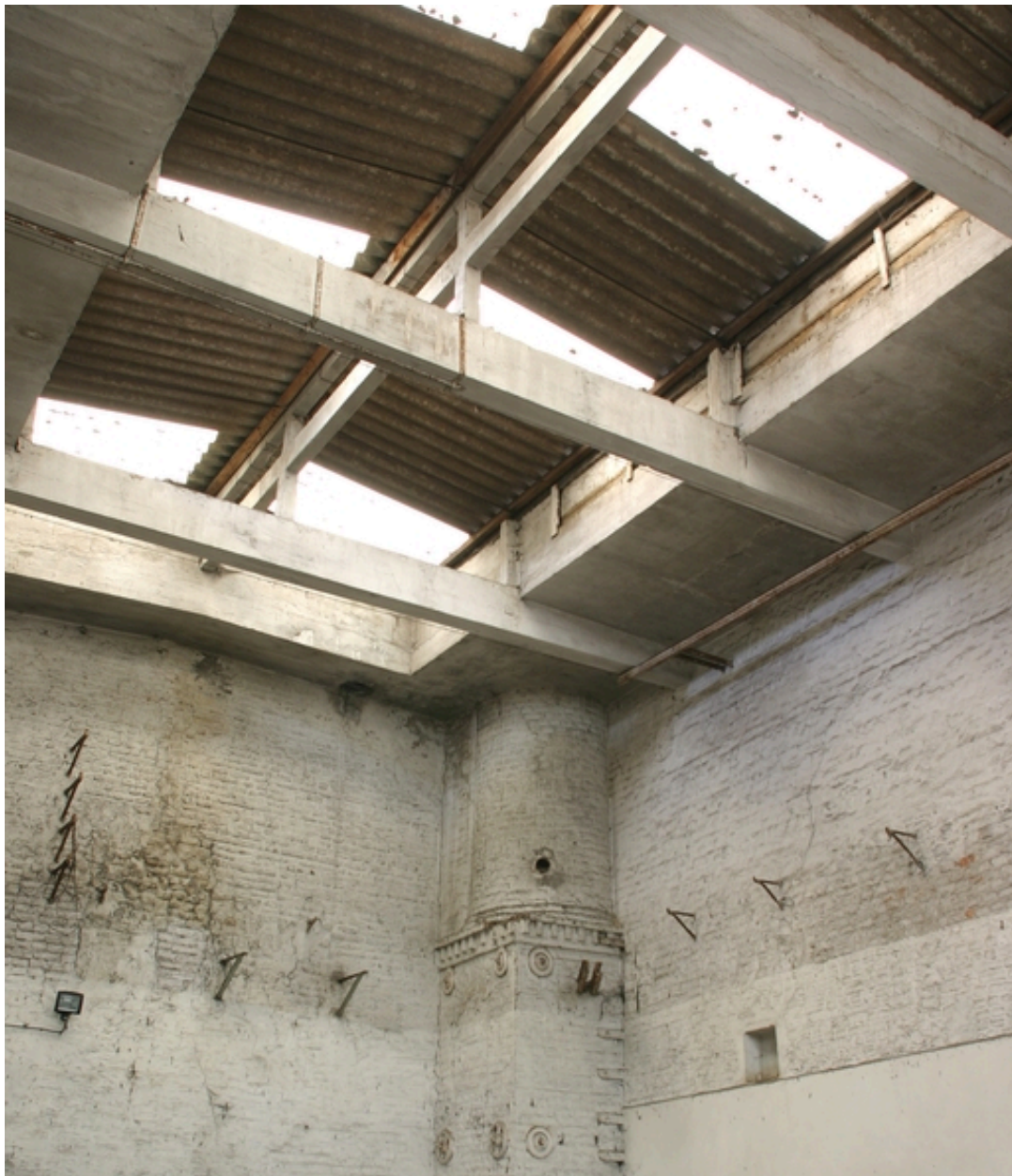
Toit-terrasse et lanterneau de la fonderie de cuivre construits entre 1897 et 1902.
