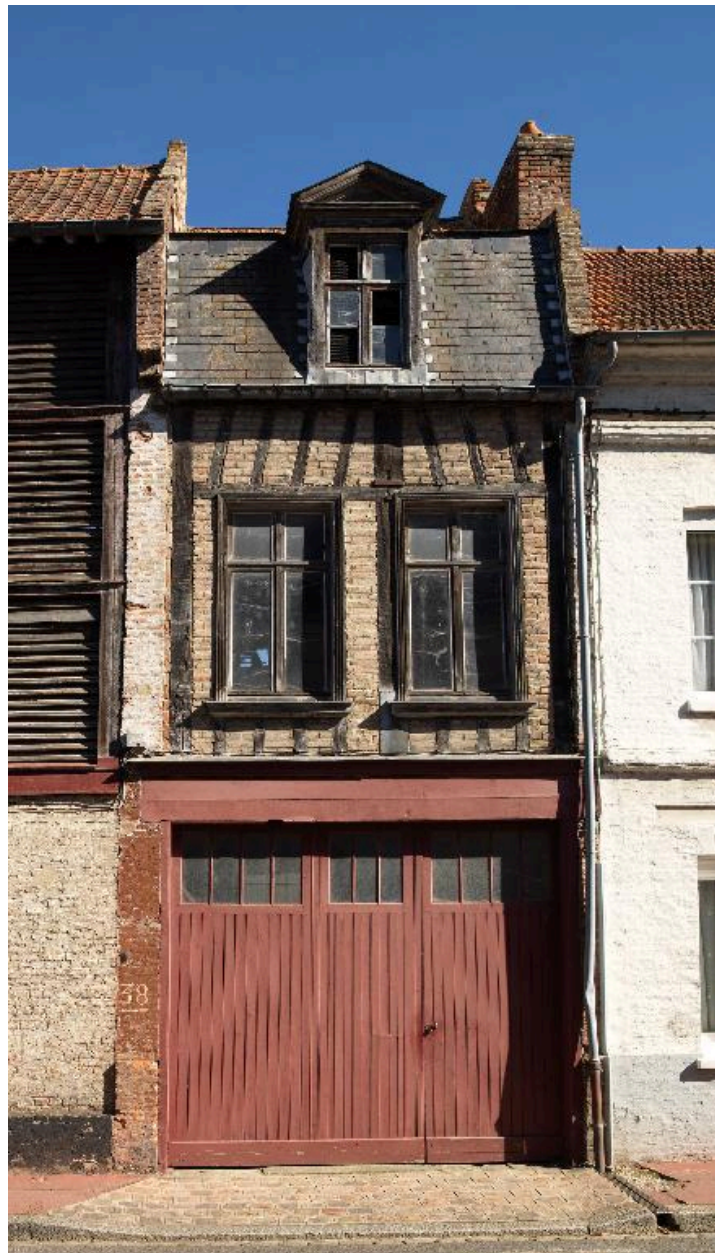
Façade du bâtiment abritant des magasins au sud.
