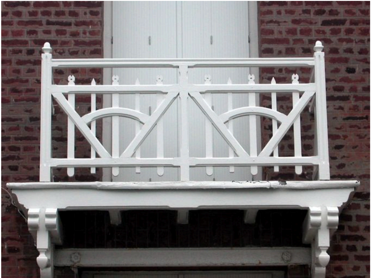
Détail du balcon.
