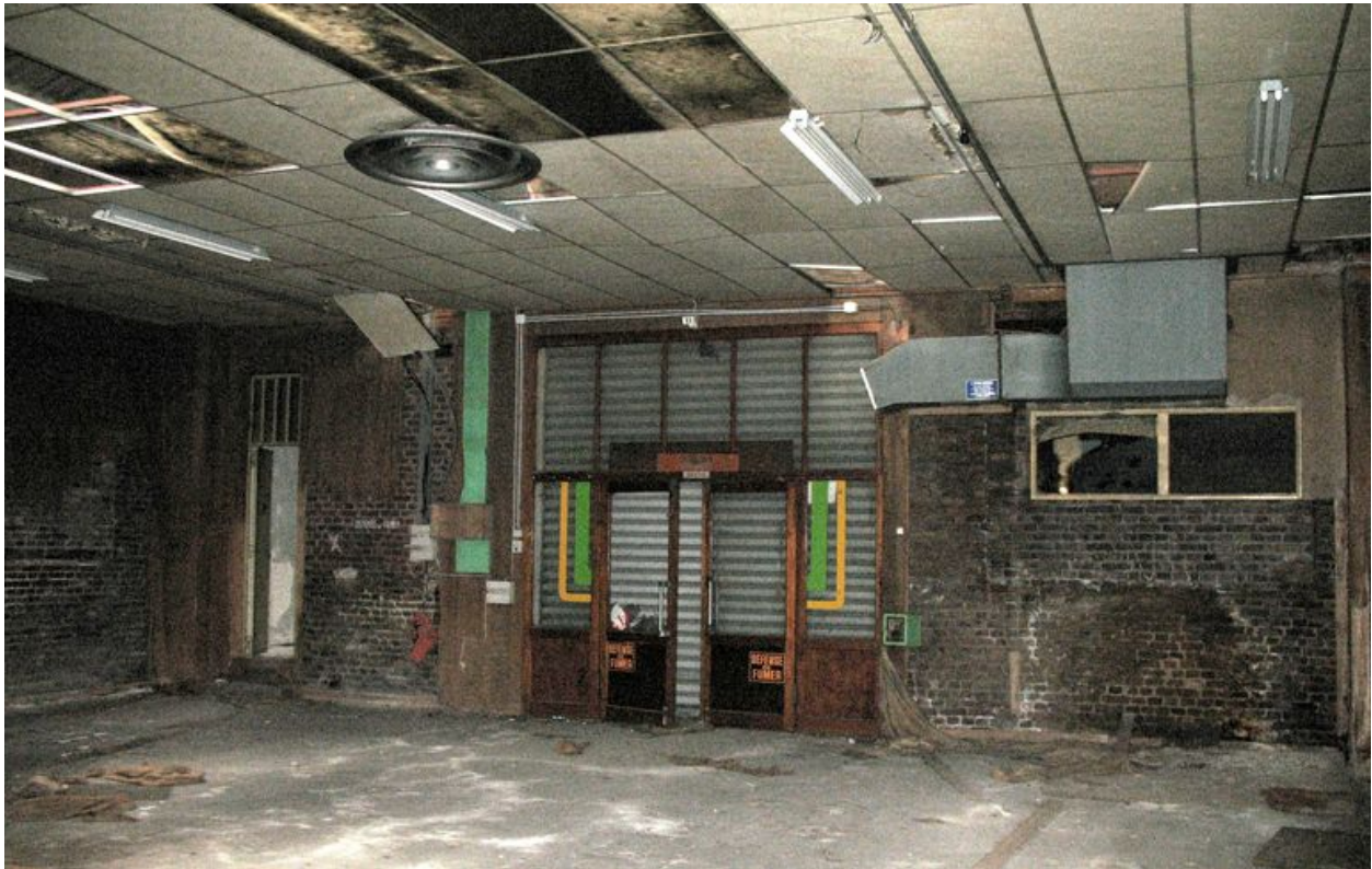
Mur pignon nord-est depuis l'intérieur.
