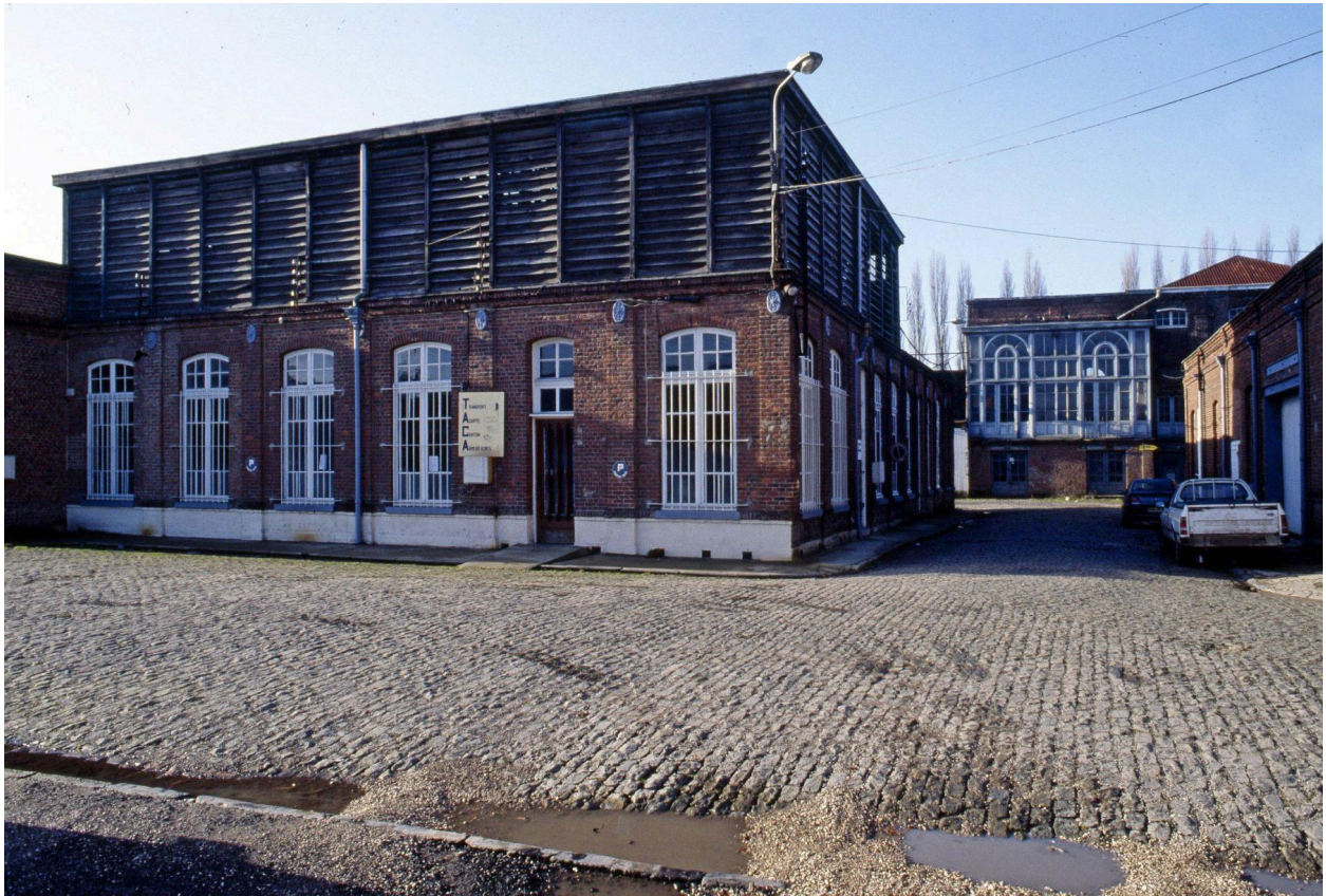
Crémage (à gauche) et salle des machines (à droite).
